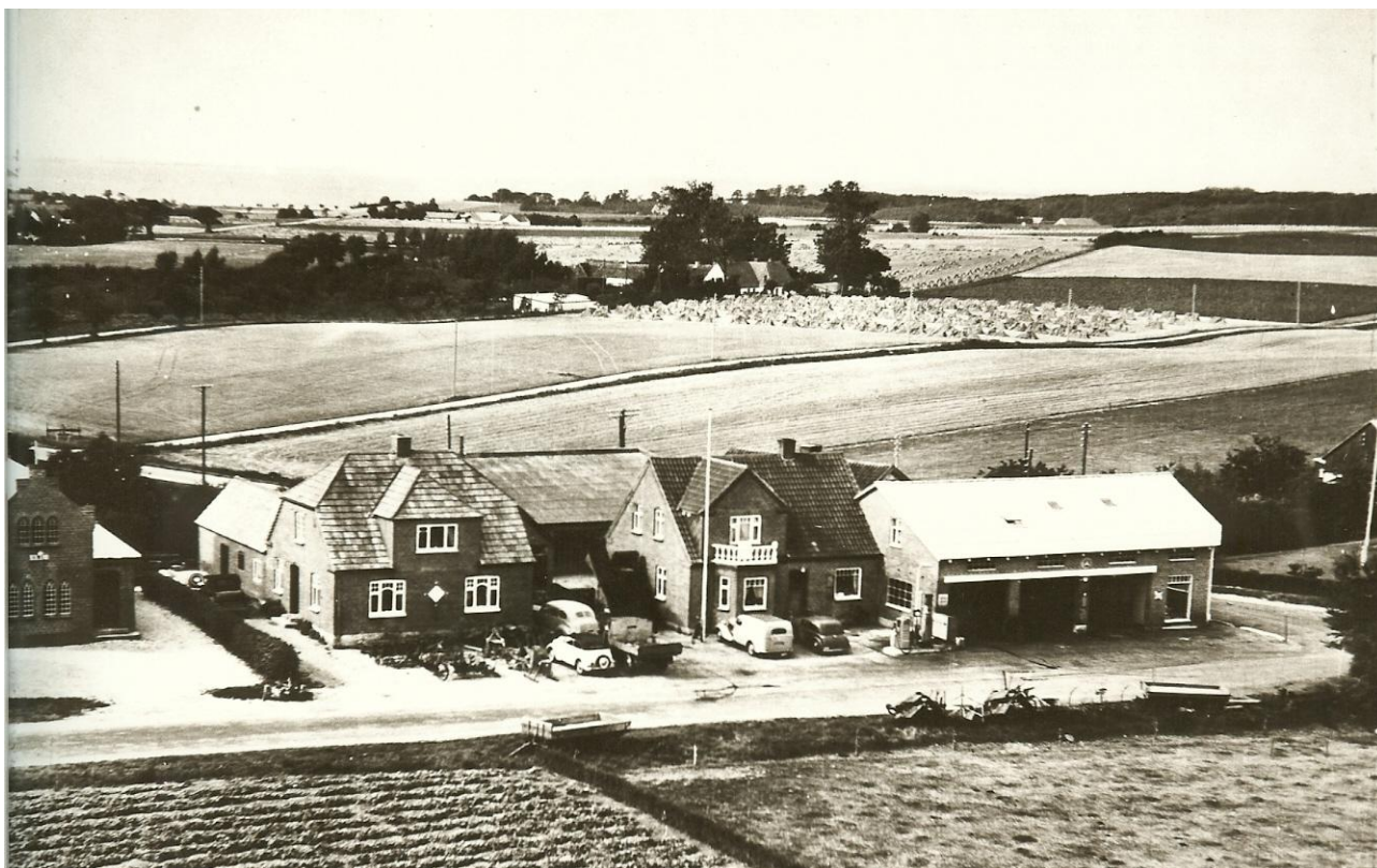
Kroers smedje i 1960'erne. Nu er den gamle smedje helt væk og afløst af et moderne garageanlæg. Benzintanken foran er Shell-benzin. Nabohuset Gl. Hovedvej 6 indgår nu i smede-komplekset.
